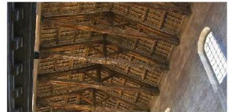
Struttura in legno, a forma di triangolo isoscele, su cui poggiano le travi e le tegole dei tetti a spiovente.
